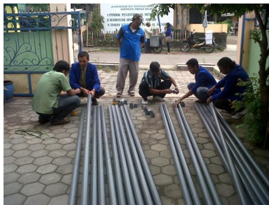
Gambar 9. Pipa-Pipa Pengganti Jaringan Lama
