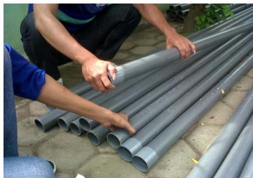
Gambar 2. Pipa Jaringan Utama Pendistribusian Air ke Warga
